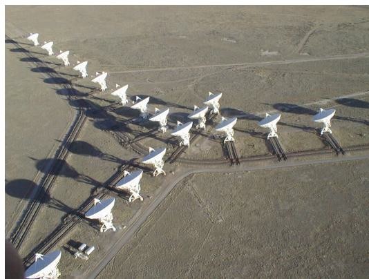
Figura 4.8: El radiointerferómetro el VLA en Nuevo México en su configuración más compacta.
